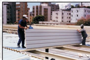
Telha térmica estruturada com poliuretano
